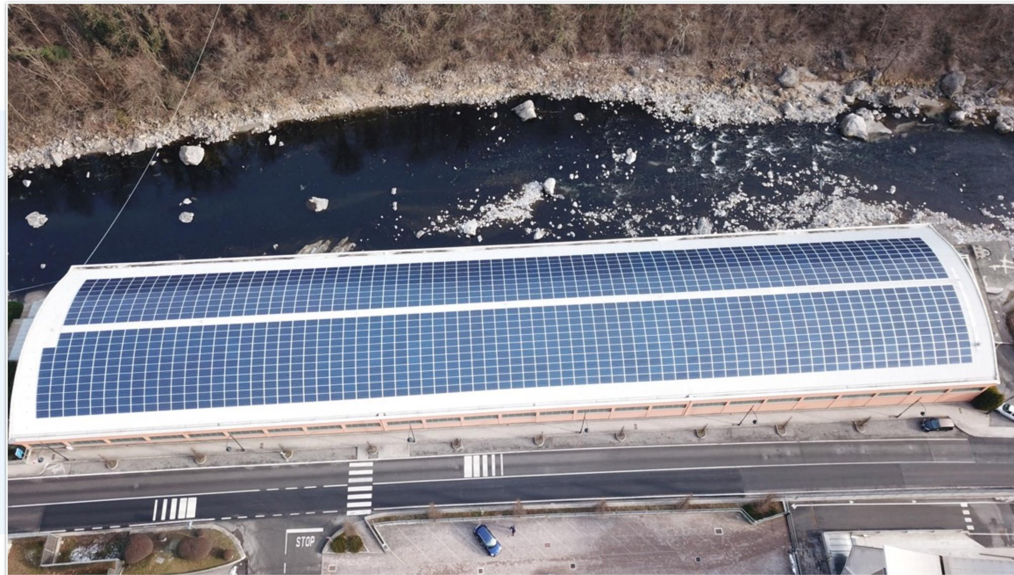
L'azienda riserva una particolare attenzione al territorio e all'ambiente; Sono stati recentemente installati 2420 m<sup>2</sup> di pannelli fotovoltaici in grado di erogare un'energia annua pari a 375 GWh (Potenza nominale 406 kW)
